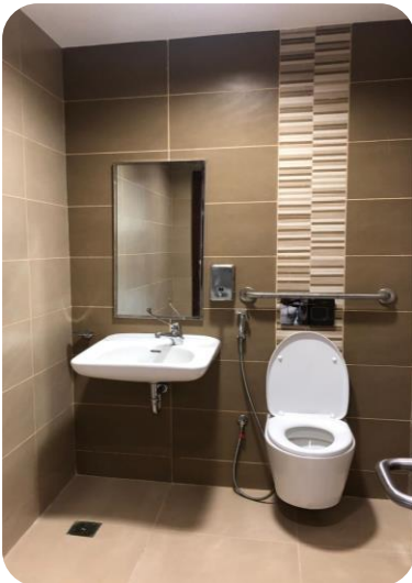
دورة مياه احتياجات خاصة
